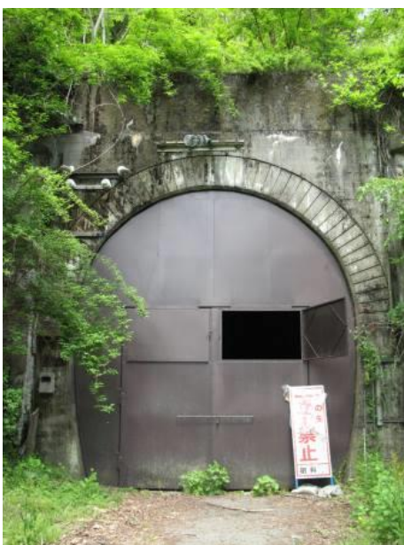
閉鎖されたトンネル
