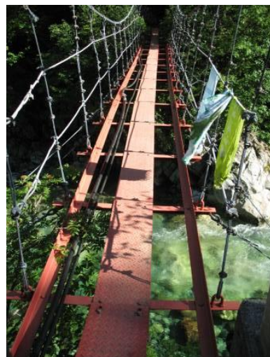
薬師沢小屋前の吊り橋
